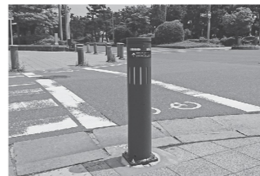
道路冠水を検知するとアラートを発信する最新の防災IoTシステム「冠水センサボード」
