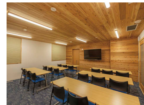
会議室 省エネ性能の高さと天井への直付が可能なのでLEDベースライトTENQOOシリーズ④を採用。
