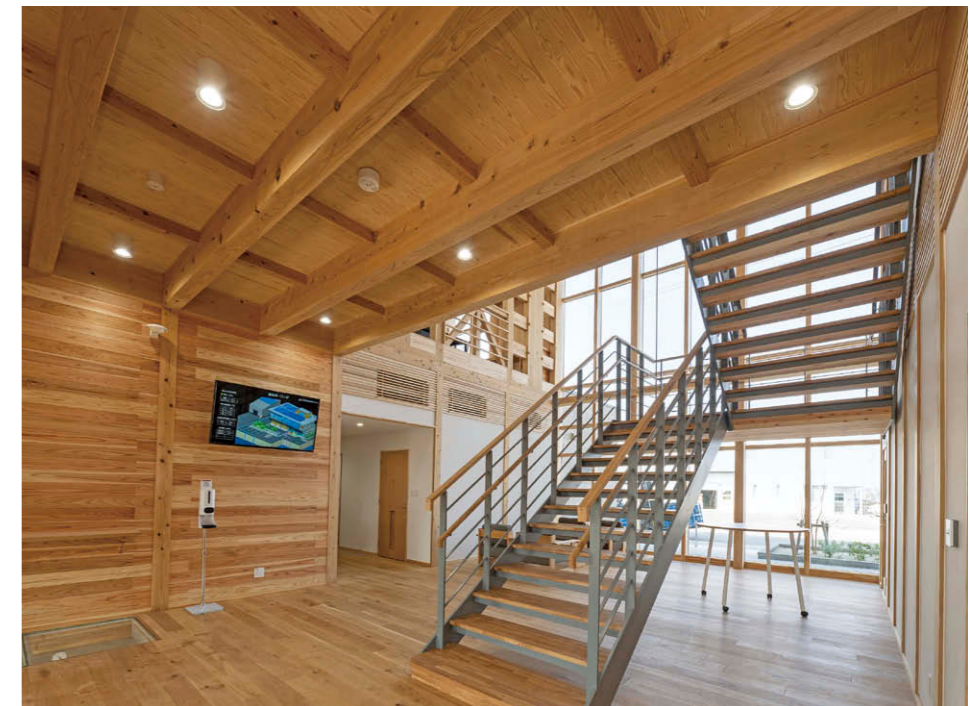
エントランスホール(1階) 天井の低い空間にはLEDユニット交換形ダウンライト直付シーリング①を採用。
