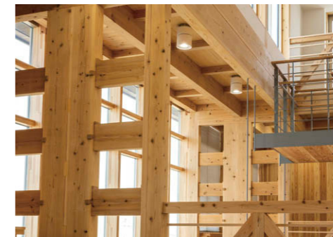
吹抜(2階) 屋光が入る吹抜の高天井部分にはLEDシーリングダウンライト②を採用。
