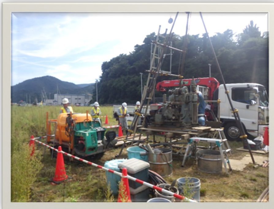
【某町 建物調査現場】
