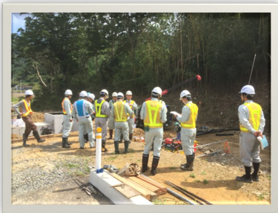
【石巻市 大原川井戸整備工事現場】
