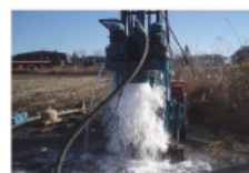
水井戸掘削工事状況
