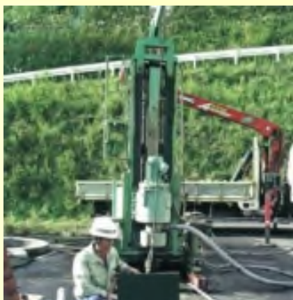
地下水モニタリング調査 (エアハンマー工法)
