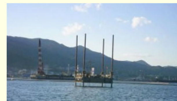
スパッド台船による海上ボーリング調査
