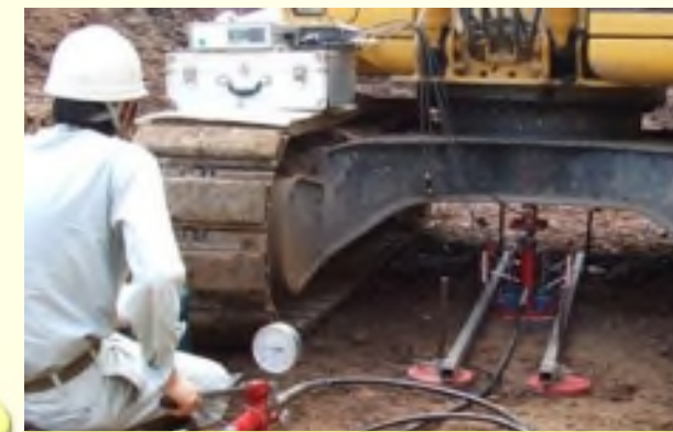
平板載荷試験による地耐力調査
