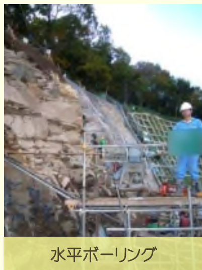
傾斜地でのボーリング調査
