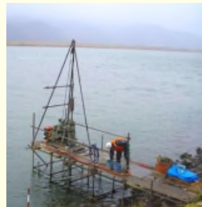
単管足場による 水上ボーリング調査
