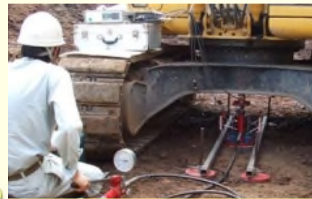
平板載荷試験による地耐力調査
