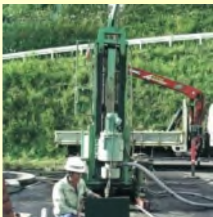
地下水モニタリング調査 (エアハンマー工法)
